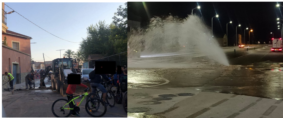
Imágenes de roturas recientes
